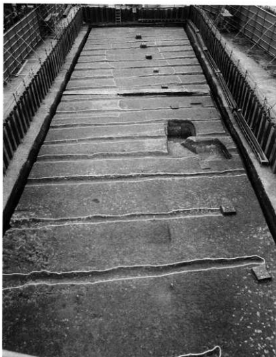
(1)第1遺構面全景(北より)
