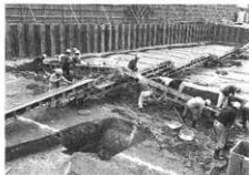
第3図 第III層掘削風景
