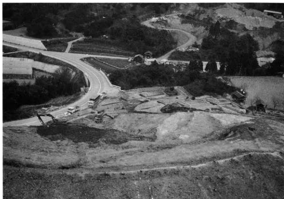
A地区全景（西から）
