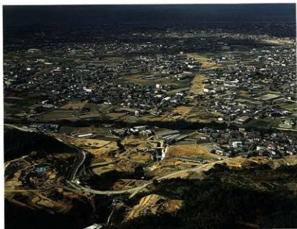
棚原遺跡上空から空港連絡道路を望む
