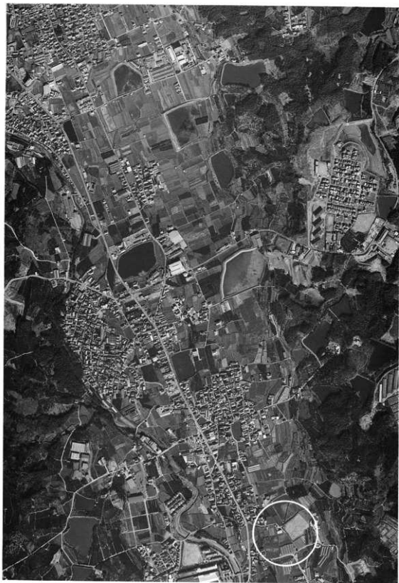
調査地全景（航空写真）
