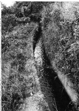
上原水路 (北から)
