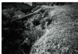
第39図版 民家裏側の掘削状況
