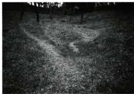
第2図版 くびれ部付近一段目斜面の道と崩落状況
