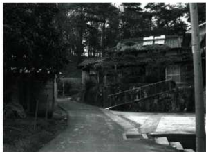
第3図版 敷地面と南側の段差（南から） 道の突き当たりが前方一段目
