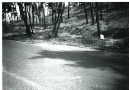
第59図版 作山段の掘削状況
