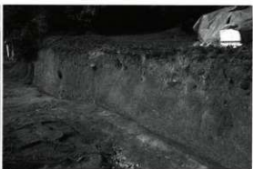
第9図版 墳丘切断面5（南東から）
