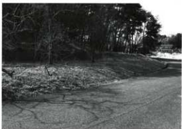
第56図版 作山段の掘削状況
