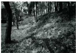
第31図版 二段目斜面の崩落状況
