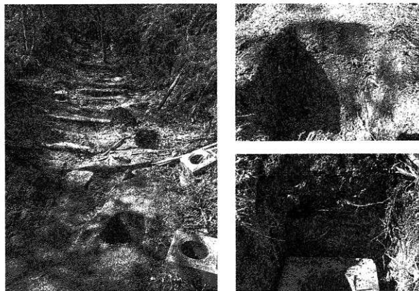
第118図版 手すり用の基礎掘削の状況と設置および掘削断面
