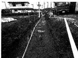
第109図版 調査状況（北から）
