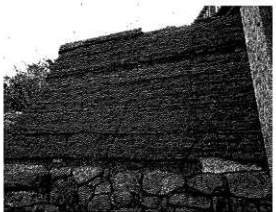
第110図版 左：③角楼北側の復元版築土塁 中：拡大 右：崩落の塊
