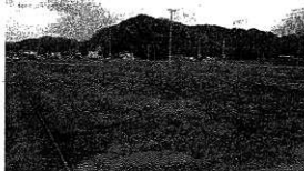
第79図版 調査状況（南東から）
