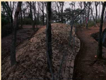
盛土して土砂の流出を止めた南土塁（南から）
