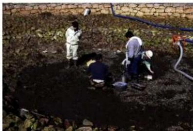
日ノ池は、金山城跡を代表する景観のひとつです。池の底には、史跡整備の過程で木炭浄化装置を設置し、恒常に水質の維持を図っています。この装置は平成8年に設置されて以来、常時移動させてきました。そこで、機器を更新するとともに、装置全般の点検を行い、併せて不要な藻類を除去しました。なお作業に当たって、一時的に池の水をすべて抜き取りましたが、終了後は再び、雨水と周りから差して来る水で満たされて行きました。
