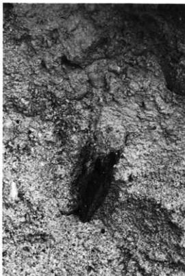
b. 自然河川崩部杭
