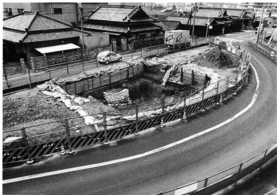
調査地全景（北西から）
