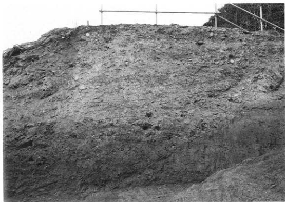
堤No.3 版築部分
