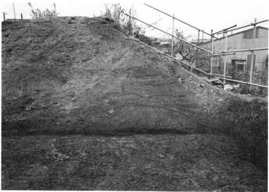
堤No. 4 芯部分
