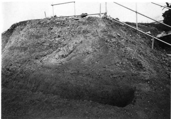
堤No. 3 芯部分
