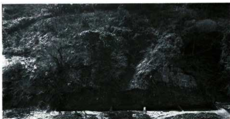
2. I区全景・西山 (東側から空撮)
