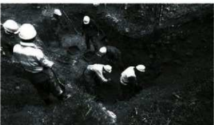
6. II区掘り下げ作業風景
