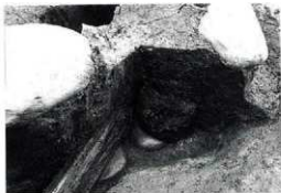
▲1. 礎石No.36下のⅡ期柱根と横木 (打ちつけられていた釘が見える)
