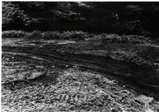
▼ 2 埋め戻し完了
