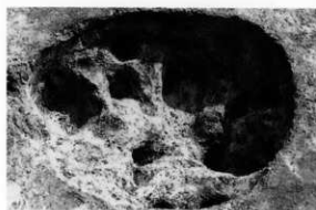
SK15 (南西より)
