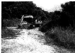
T1501表土除去状況（南より）
