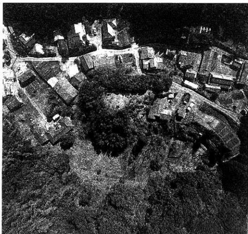
3次調査区周辺航空写真(上が南)
