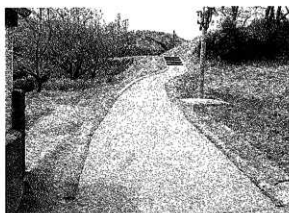
写真13 管理用道路敷設状況（東より）
