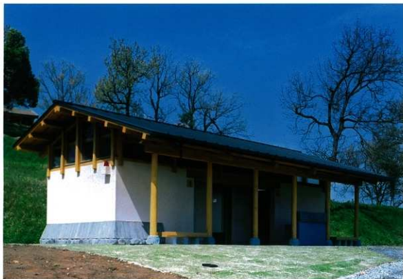
写真16 トイレ竣工写真(東より)
