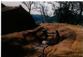
写真20 ソイルセメント吹き付け (東より)
