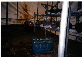
写真26 ジェットヒーターによる石材乾燥
