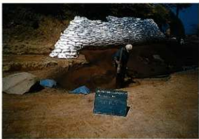
写真28 ソイルセメント吹き付け（南東より）
