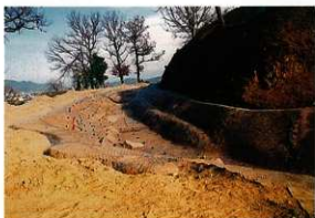
写真19 ラス張り付け状況 (西より)
