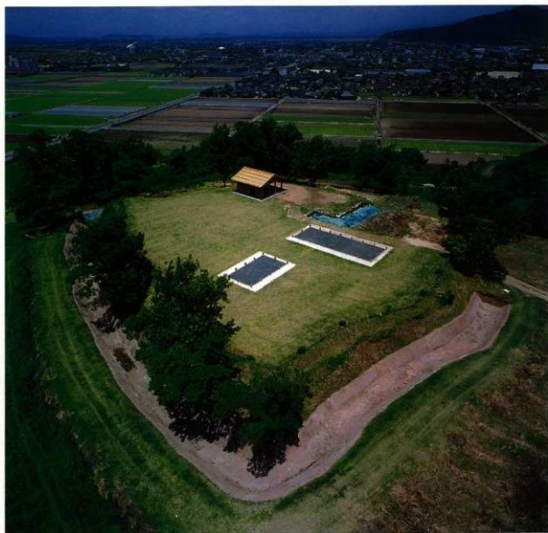
写真16 千畳敷周辺整備状況（南西より）
