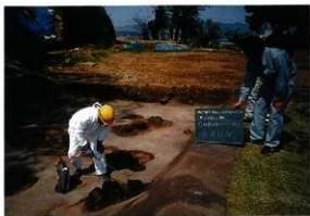
写真29 石材撥水処理（南より）
