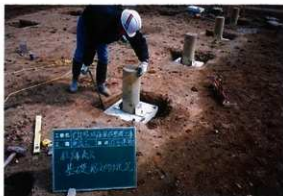
写真25 柱跡表示基礎据付(17号建物)
