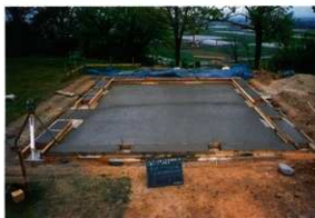
写真29 基礎コンクリート打設
