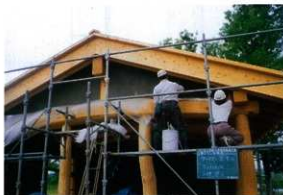
写真31 外壁工事（下地塗り）
