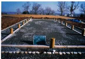
写真26 洗い出し舗装路盤完了状況(16号建物)
