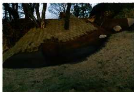
堰・開渠整備状況
