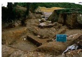
堰・開渠整備前状況（北西より）
