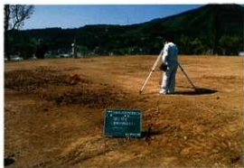
千疊敷保護盛土状況
