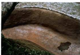
千畳敷南西側内堀整備状況
