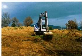
千疊敷表土すき取り状況
