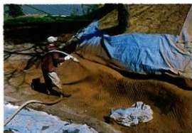
ソイルセメント吹付け状況
