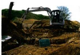
堰・開渠保護盛土状況
