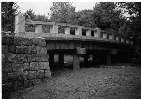
高砂公園に移築された伽羅橋
