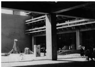
写真31 コンクリート壁（左奥） （工学院大藤森研究所蔵）
