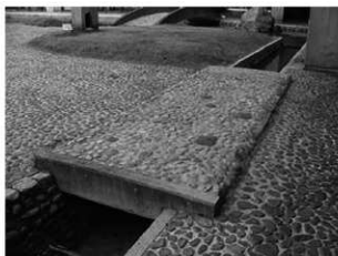
写真15 東側水路の橋（広場とピロティの間、現況）
