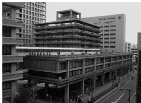
写真39 現在の香川県庁舎旧本館
