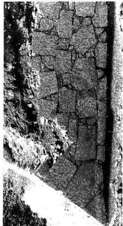
B-T5-e 石垣 (東から)
