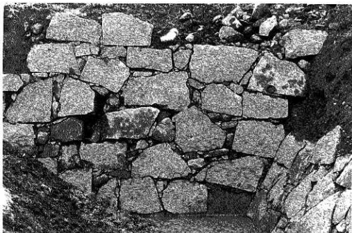
B-T6-e 石垣 (北から)
