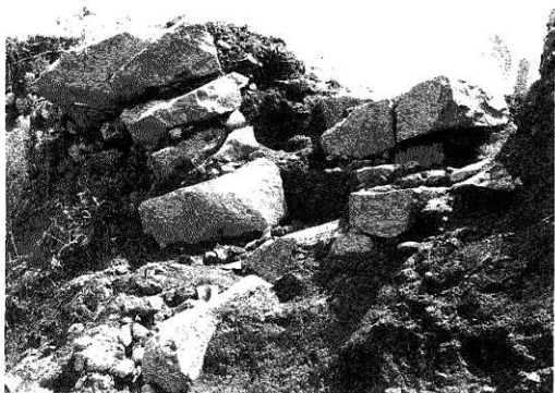
S A - 4（北東から）
