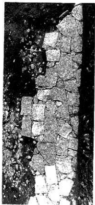
B-T4 石垣 (南から)
