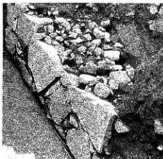
Fig 40 石垣裏込めの状態 (西から)
