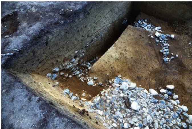
2. 造出し部南東側 下段斜面崩落状態 (第5次K区：西から)
