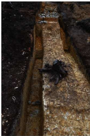
2. 造出し部中央 中段平坦面盛土下の列石 (第2次B区南西側:北東から)
