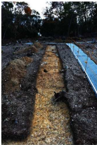
3. 造出し部南東側 中段平坦面検出状態 (第2次B区南東側:北西から)
