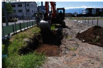
調査開始 A区(東から)
