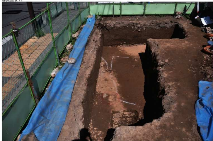
C区 I検完掘状況(西から)
