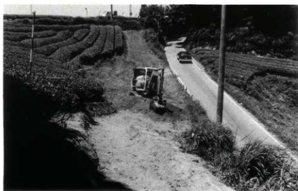
重機稼働風景
