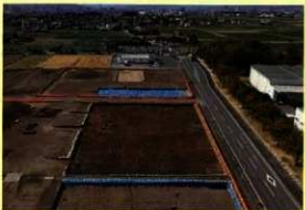
遺跡全景(東方向から)
