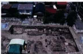
▲調査地(南から撮影)
