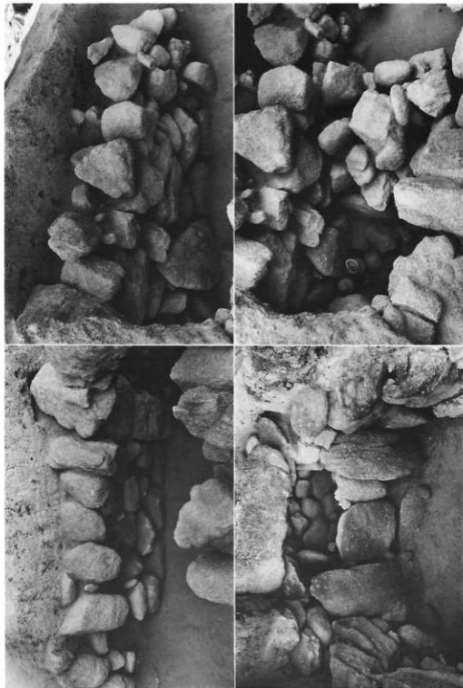
英道 上左：左側壁，上右：右側壁，下左：閉塞状況(玄室より)， 下右：閉塞状況(北より)
