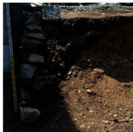
SX600石垣断面 (北東から)
