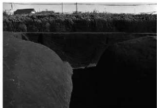
SZ06 土面断層 南より
