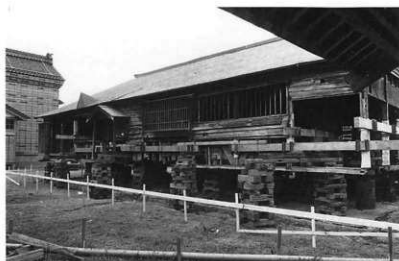
4 掃屋工事 各所修理の前にまず掃屋をおこなって基礎と土台の修理と、地上げをおこなった。その際、あらかじめ行った調査に基づいて復元の部分の基礎廻りを同時に施した。
