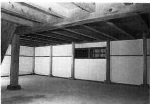
図16 同上 修理後の状況
