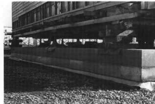
6 新基礎 (地上げによる) の据付
