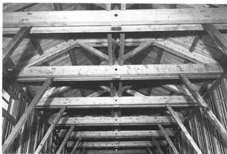
石蔵 小屋組（文書倉に使う） 北より見る
