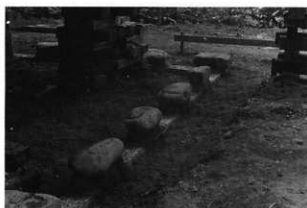
3 基礎工事 礎石据付 (コンクリート基礎の上)
