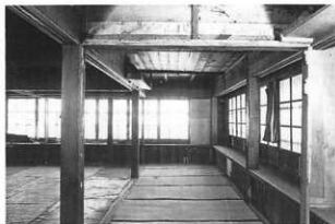
4 修理前 「船頭部屋」 南より見る
