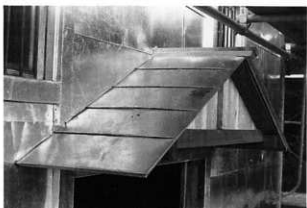
6 外壁鉄板覆い 外壁、庇屋根
