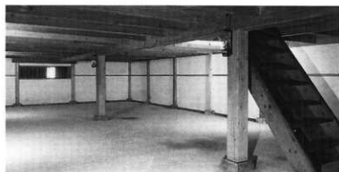
7 竣工内部 地階 南から見る
