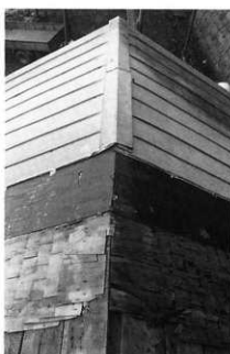
6 解体中 屋根断面
