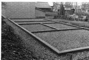
4 布基礎復原完了
