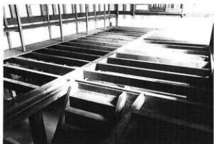
3 解体中 1階床組
