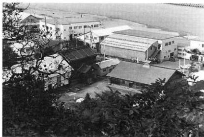
1 石蔵工事中の風景 背後の山上から俯瞰
