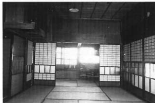
3 修理前 「中の間」 西面
