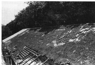
2 解体中 鉄板を剥した状況 桁葺が残存した
