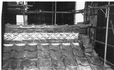
同上 修理後の状況
