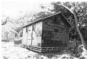
2 修理前 正面 西北より見る
