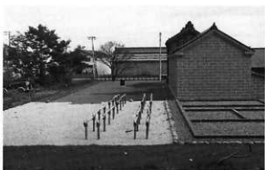
図70 白子干場施工状況
