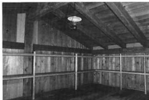
5 竣工 内部2階間仕切
