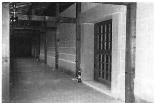
4 竣工 下屋内部 本体面
