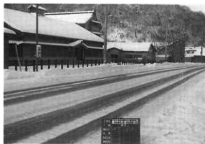
図80 国道沿い保護柵施工状況
