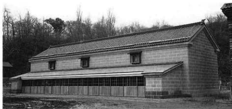
石蔵（復原新築） 正側面 北東より見る
