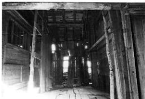
4 修理前 取合部 左便所、右物置
