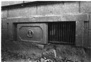
図18 修理後の状況
