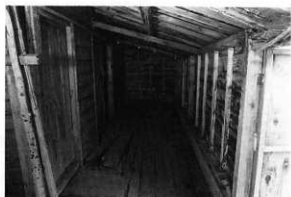
5 修理前 後設下屋 手前便所、先方物置
