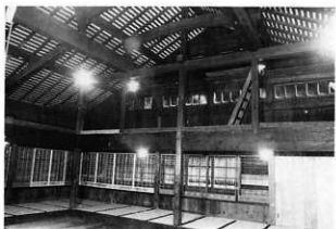
5 組立中 「漁夫溜場」 西南より見る
