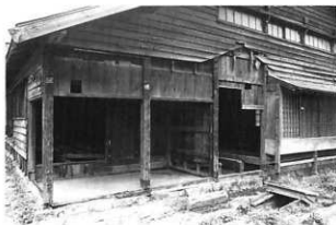
2 同左撤去後の本体軸部 壁の痕跡
