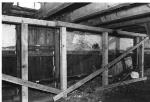
4 修理前 地階現状
