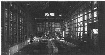
3 木工事 軸組組立、小屋組加工中
