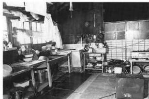
5 修理前 「台所」 東より見る
