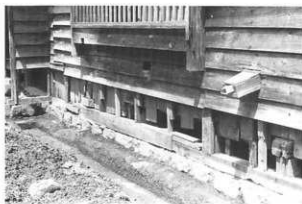
2 修理前 基礎と排水溝
