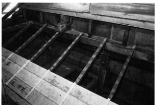
6 解体中 西面下屋 改造がみられる
