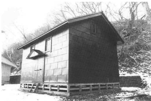
1 竣工 正側面全景 西北より見る
