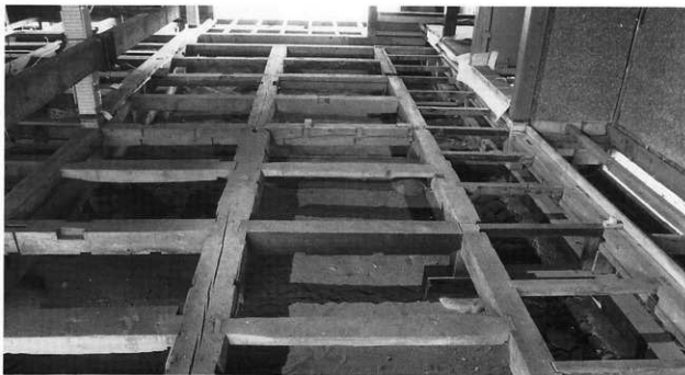
3 解体中 座敷床組 北より見る
