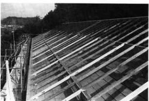
5 木工事 垂木の取付、一部取替
