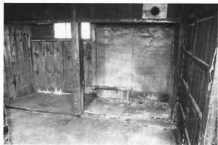
1 後設東面下屋の内部
