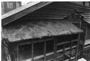
1 解体中 東面下屋（後設）の解体
