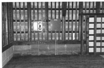
図31 石蔵 設備関係壁の設置状況
