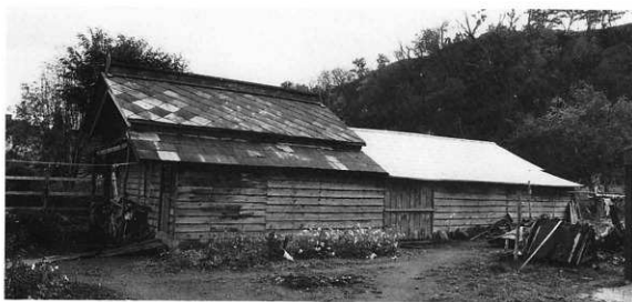
1 修理前 便所・物置 左が便所、右が物置。物置の取合屋根と両方の下屋は後設。
