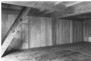
3 竣工 内部1階 東妻
