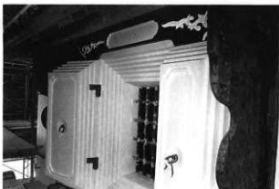
5 左官工事 北裏窓扉漆喰塗り直し
