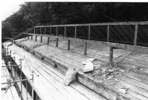
4 木工事 小屋組修理、不陸調整
