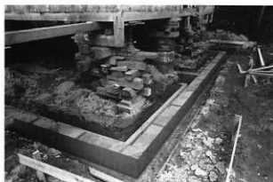
2 揚屋、基礎工事 コンクリート布基礎打ち
