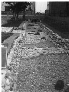
図61 水路整備後 (下流)
