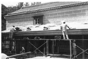
1 屋根工事 下屋桁葺作業中
