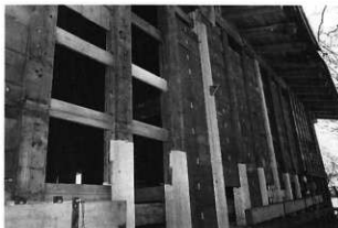
2 木工事 軸部の修理
