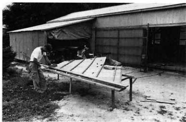
図20 文書倉 外壁羽目板の作製
