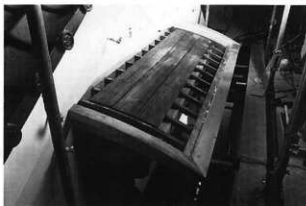
3 木工事 北面庇の修理 (解体・組立)
