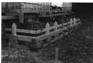
4 木工事 土台・東据付
