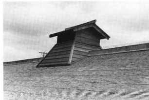
6 竣工屋根及びび障出し
