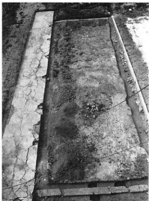
1 地下遺構全景 文書倉屋根より見る
