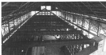
4 木工事 小屋組陸梁架構
