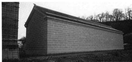
石蔵 背面 西より見る
