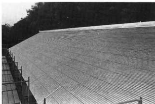
1 屋根工事終了
