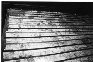
1 屋根工事 土居葺 (檜皮) 葺替
