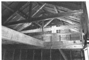
5 竣工 内部2階、小屋組西面
