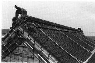
2 屋根工事 瓦葺終了
