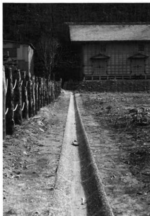
図44 皿型側溝布設状況 (主屋より米味噌倉方面)
