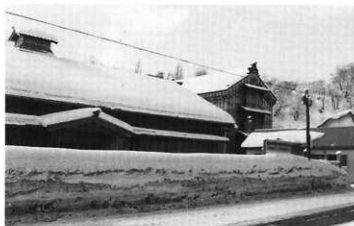
図 32 冬期の現場状況
