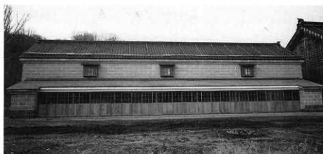
石蔵 正面 東より見る
