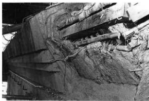
2 解体中 軒土塗及び地下断面
