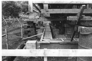
5 基礎コンクリート工事 (旧礎石の上に据付)
