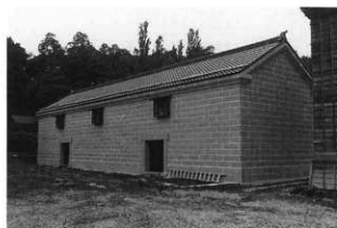
3 本体工事（外廻り）終了 下屋工事準備
