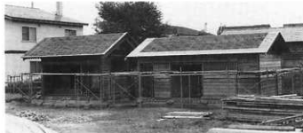
5 組立中 木工事終了 屋根工事直前の状況
