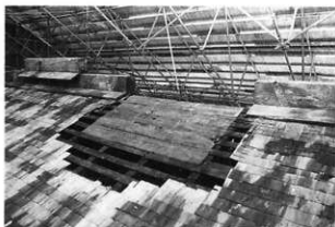
4 解体中 屋根 煙出し棟の痕跡
