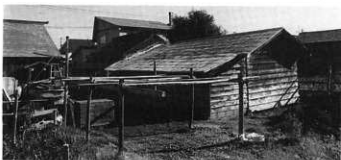
2 修理前 物置 南西より見る 下屋、便所取合は後設
