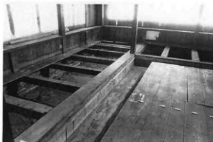
2 解体中 「漁夫溜場」床組 西より見る
