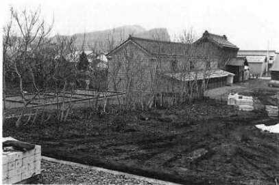
2 雑倉工事（布基礎復原）終了後の敷地全景
