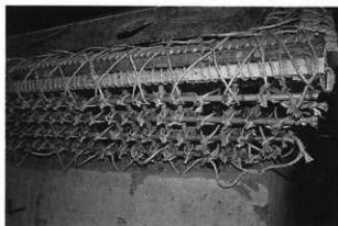
2 左官工事 軒土塗下地編み直し
