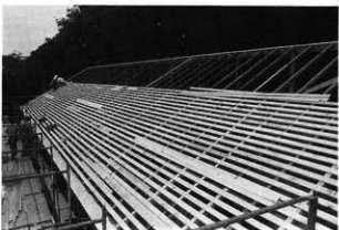
6 木工事 野地木葺打ち 全部新材に取り替えた
