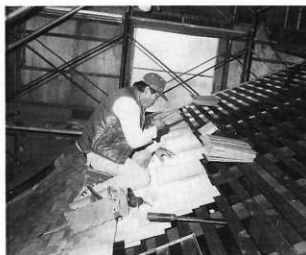
2 屋根工事 桎葺
