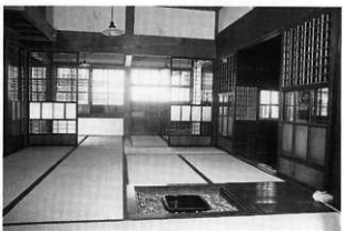
5 竣工 「茶の間」から「帳場」を見る
