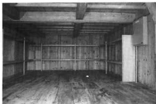
4 竣工 内部1階西妻
