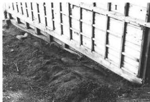
4 同左 外側状況
