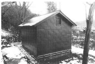
3 竣工 背側面 東南より見る
