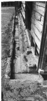
3 修理前 埋まっていた排水溝
