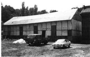
2 素屋根 東北から見る
