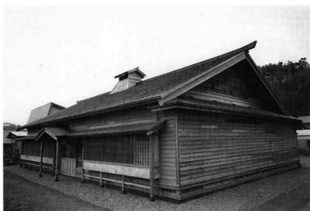
主屋 正面面 北面より見る
