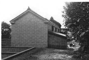
2 下屋廻り工事終了
