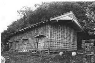
1 修理前 正側面（北西面）全景
