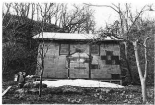
1 修理前 正面 (北面)
