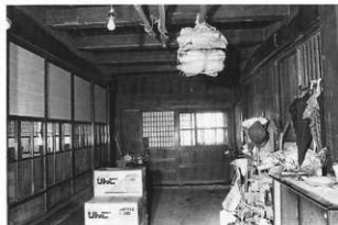
6 修理前 「庭廊下」 南より見る
