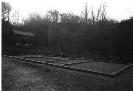
雑倉 基礎まで復原 北東より見る
