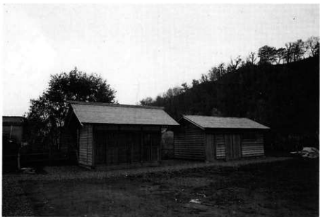
便所・物置 西より見る
