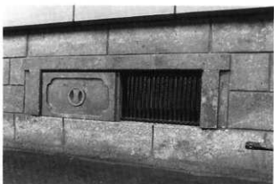
6 基礎工事 地階窓修理
