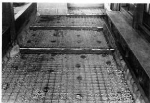
4 組立中 「寢廊下」土間コンクリート打ち
