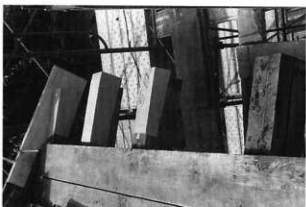
3 木工事 垂木・破風板軒先修理
