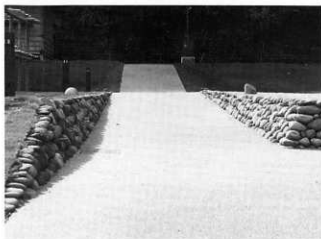
図42 スロープ(中央)と石積擁壁(右・左側)の状況
