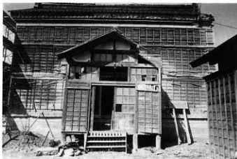
1 修理前 正面(東面)
