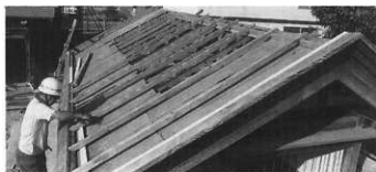
4 組立中 軒廻り部材取付修整
