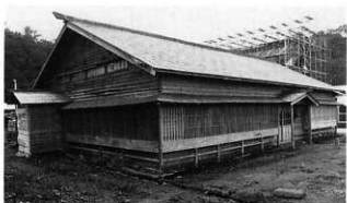
3 修理前 正側面 北東より見る
