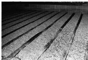
5 木工事 本体内部 根太組砂利詰終了
