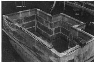
3 組立中 基礎（便槽を兼ねる）組積
