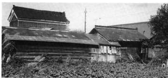
3 修理前 便所・物置背面 東より見る
