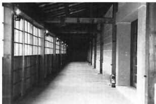
3 竣工 下屋内部 北より見る
