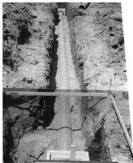
図43 VU管パイプ布設状況
