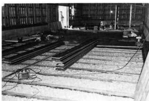
6 木工事 本体内部 床板張作業
