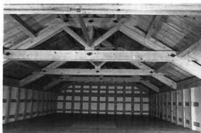
1 竣工内部 3階南面
