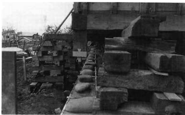
基礎工事(持揚)
