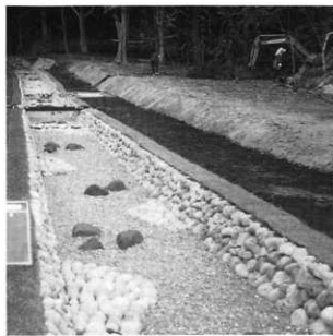
図60 水路整備後 (上流)
