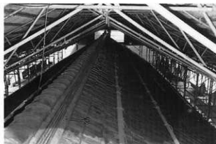
1 屋根工事 屋根棧瓦葺終了
