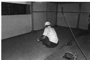
4 基礎工事 地階床土間叩き
