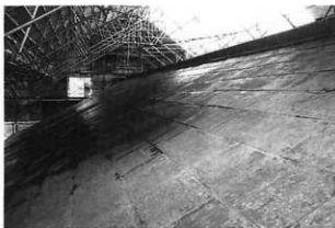
3 素屋根の建設
