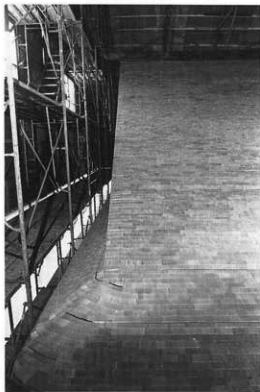
3 屋根工事 桎葺葺上り 西妻南より見る
