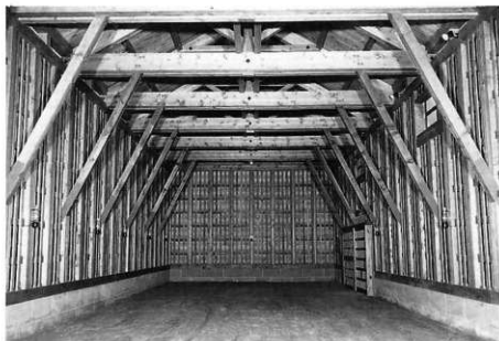
石蔵 内部（方杖は補強） 南より見る
