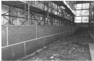
2 同 地下コンクリート基礎上に布石積
