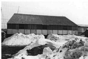
1 素屋根 背面全景
