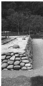
図41 石積擁壁施工状況
