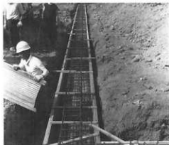
1 基礎工事 地下遺構を撤去してコンクリート基礎を設けた
