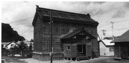
3 竣工 文書倉全景 東面より見る
