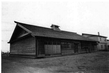
主屋 背側面 南西面より見る
