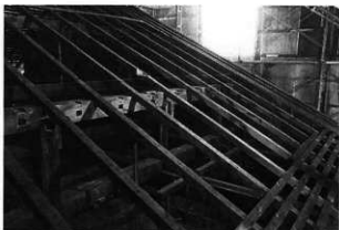
5 解体中 屋根 転用材を使用した母屋
