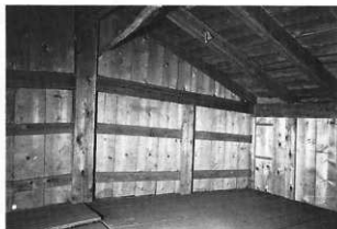
6 修理前内部 2階間仕切
