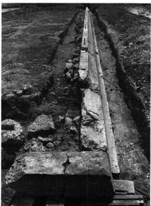
4 地下遺構 背面コンクリート布基礎
