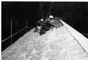
5 屋根工事 土居葺 (サワラ材)
