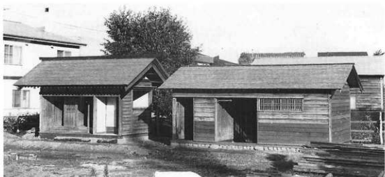
1 竣工 便所・物置 西より見る
