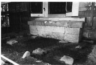
6 解体中 前室解体後、礎石状況
