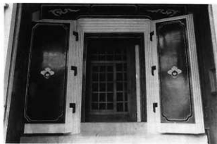
1 竣工 入口扉廻り
