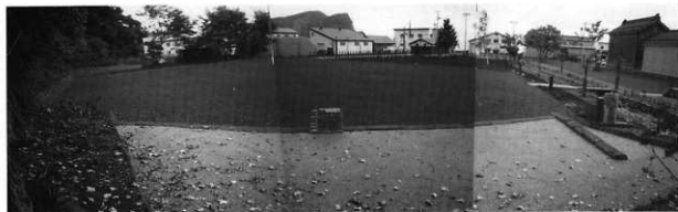
写真9 干場ダスト舗装状況
