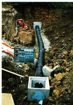
写真19 排水パイプ伏設状況
