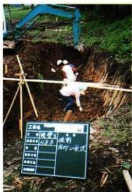
写真25 擁壁工(掘削・床均し)
