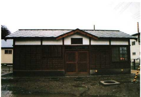
写真34 便益施設(完成)
