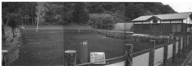
写真4 園路・広場完成後
