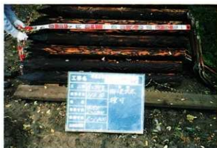
写真27 焼丸太寸法確認 (L=1,800)
