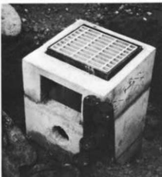
fig.-16 園池池底集水井施工状況
