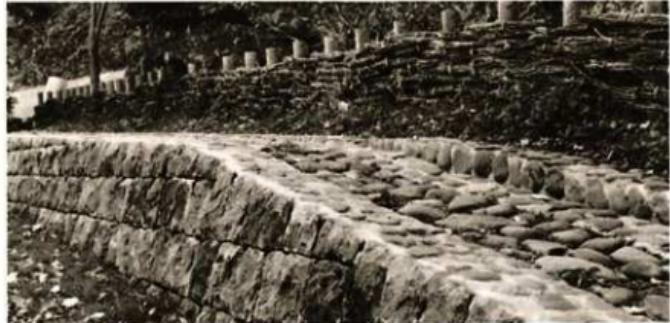
写真-31 外周玉石揃積排水溝・擁壁
