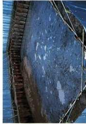
矢張り状況 NE-SW
