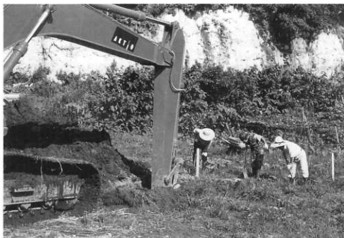
トレンチ状況 (第25トレンチ)
