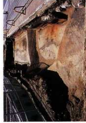
H-1-2線状況 (南東→北西)
