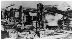
写真24 ニシン釜と圧搾機 （『鯨漁業写真報』より転載）
