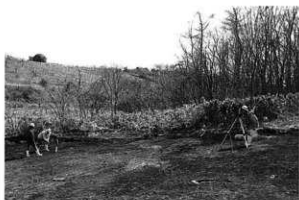
測量杭打設作業
