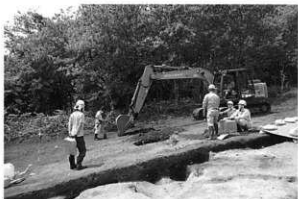
調査区外南の試掘作業
