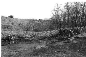
測量杭打設作業
