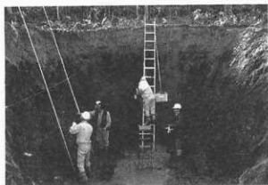
写真 1 トレンチ全景写真
