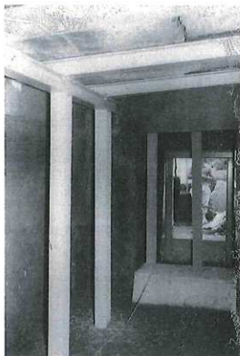
奥室側からみた中室（東側壁）と玄門
