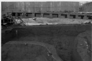
SX04 土層断面 南から
