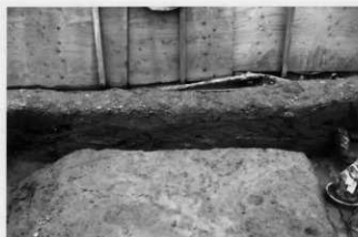
SF01 路盤断面 西から
