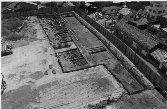
B区 北東から
